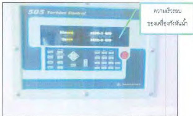
รูปที่ 2 ความเร็วรอบของเครื่องกำเนิดที่ Woodward 505
