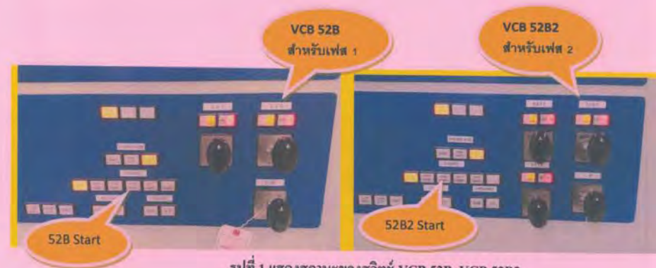
รูปที่ 1 แสดงสถานะของสวิตช์ VCB 52B, VCB 52B2
